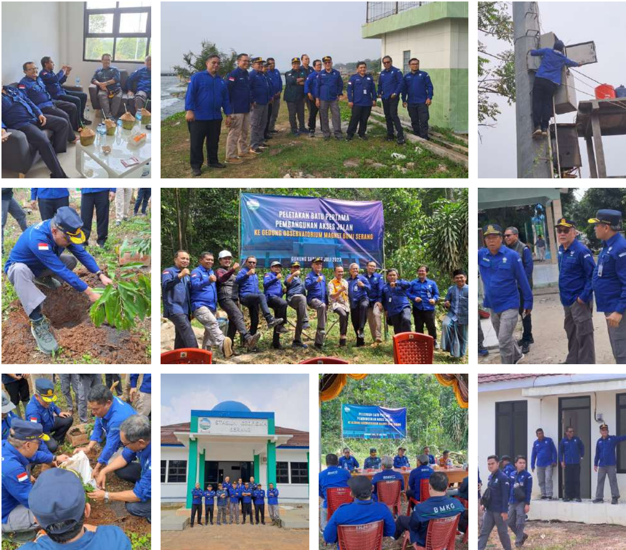
Gambar 31. Dokumentasi kegiatan kunjungan kerja Sekertaris Utama BMKG dan Peletakan Batu Pertama Pembangunan Akses Jalan BMKG Observatorium Magnet Bumi Serang.
